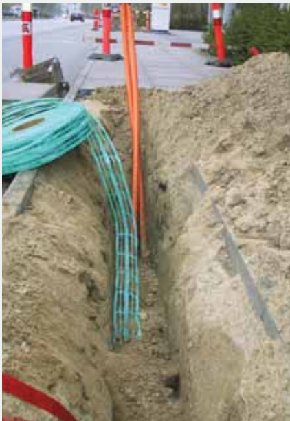
Udlægning af kabelrør og advarselsnet
