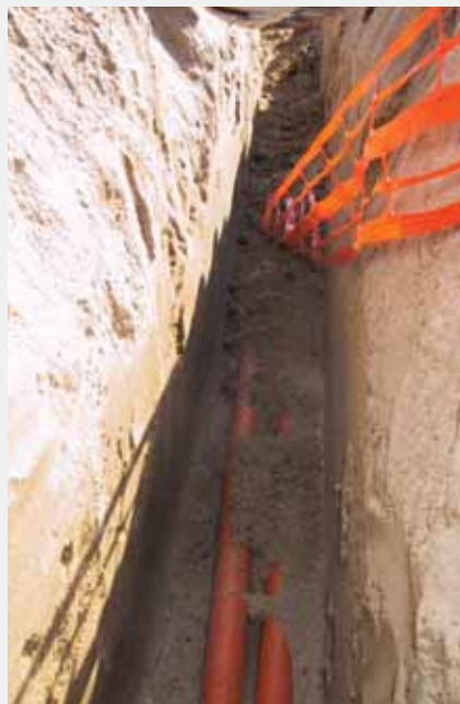
Udlægning af kabelrør og advarselsnet
