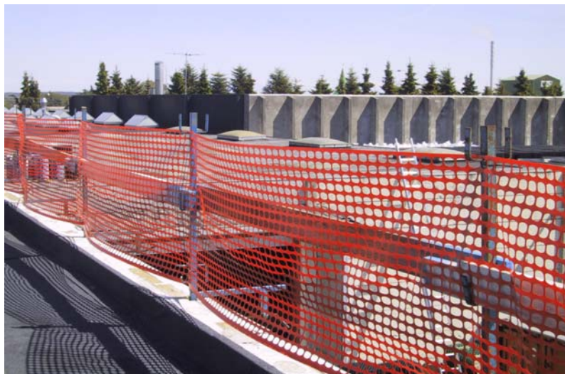
Afspærringsnet type F23 monteret på byggeplads sammen med sikkerhedsstakit giver en tydelig afspærring.
