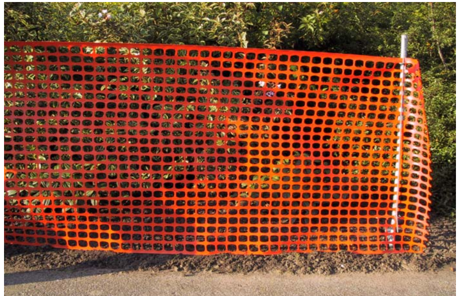
Afspærringsnet type F23 monteret i jordunderlag til afgrænsning mellem vej og rabat.
